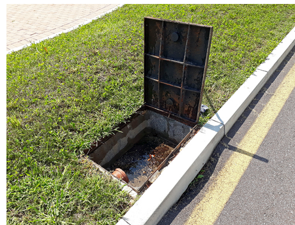
Verifica in una bocca di lupo
