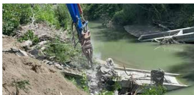
Nel mese di luglio si sono conclusi i lavori di rimozione delle macerie del ponte della Pedagna, crollato durante l'alluvione del settembre 2024.
